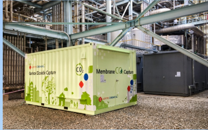
롯데케미칼 여수1공장에 설치된 탄소포집 설비로 CCU에 활용된다.
